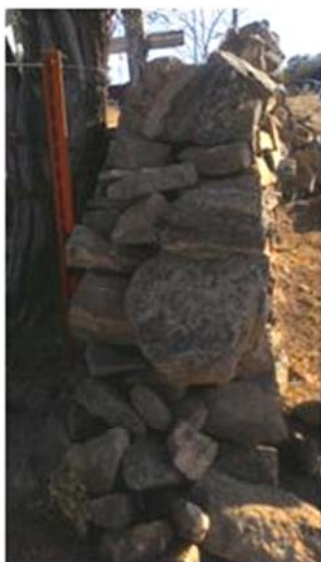
Figura 8: Detalhe transversal do muro em alvenariade rocha na zona rural de Caicó, RN.
