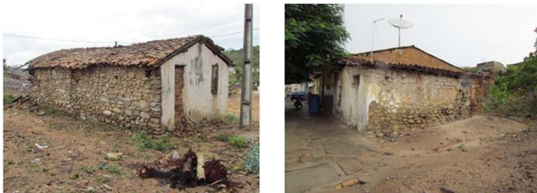
Figura 12: Casas construídas com alvenaria de rocha e rejunte de barro na zona rural de Pesqueira-PE. Nos dois casos percebe-se a ainda a presença de reboco. As alvenarias de rocha dessas residências seguem o modelo de emprego de rochas do entorno sem ou com pouco trabalho de cantaria. Nesses dois casos a paginação é irregular e as rochas maiores foram colocadas na parte inferior.
