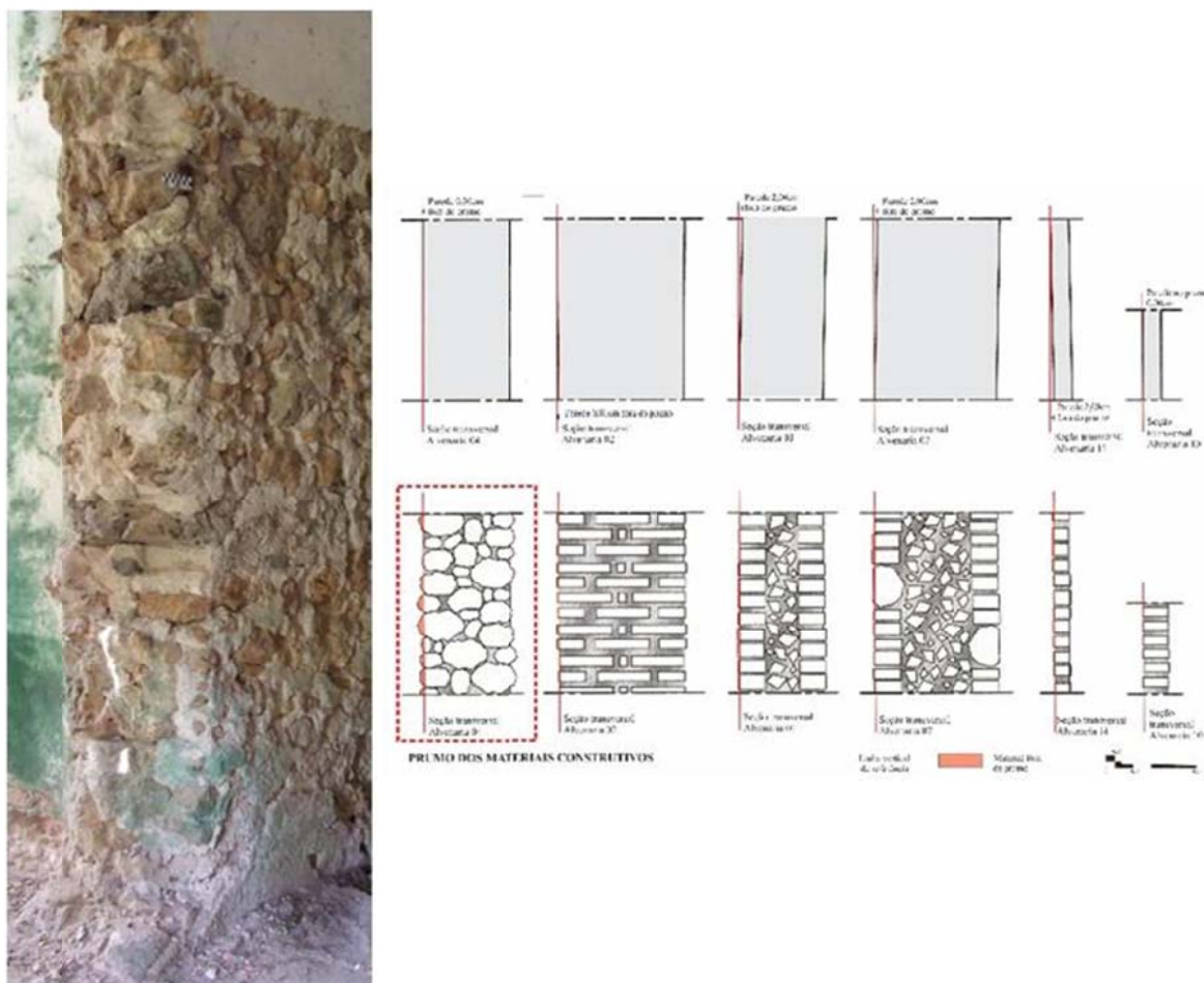
Figura 3: Exemplos de alvenarias identificadas no engenho Monjope. A rocha é empregada no recheio das alvenarias ou, como em algumas paredes, na sua totalidade. No detalhe a alvenaria de rocha com argamassa de barro, com largura variando de 38 a 44 cm. Essa alvenaria utiliza rochas de tamanhos variados, sem tratamento de superfície. Da esquerda para a direita, a sequência das alvenarias condizem com as ampliações (fases construtivas) do casarão e não representam aprimoramentos ou melhorias técnicas ou tecnológicas lineares e crescentes, mas modelos construtivos diversos decorrentes da vicissitudes e circunstâncias econômicas e da disponibilidade de matéria prima e mão de obra de cada época.
