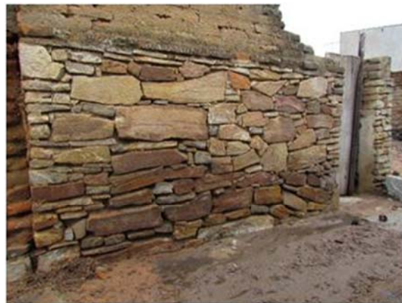
Figura 11: Muro divisor de lote em um distrito na zona rural do município de Pesqueira-PE seguindo o padrão de alvenaria com junta seca. Note-se que se manteve um prumo nessa parede, independentemente da irregularidade geométrica das rochas.
