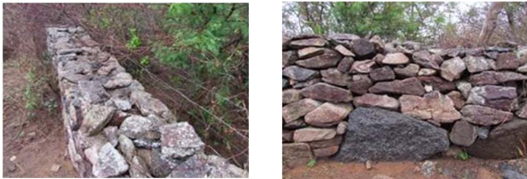
Figura 10: Face superior e vista lateral de muro de rocha e junta seca na zona rural de Pesqueira, PE.
