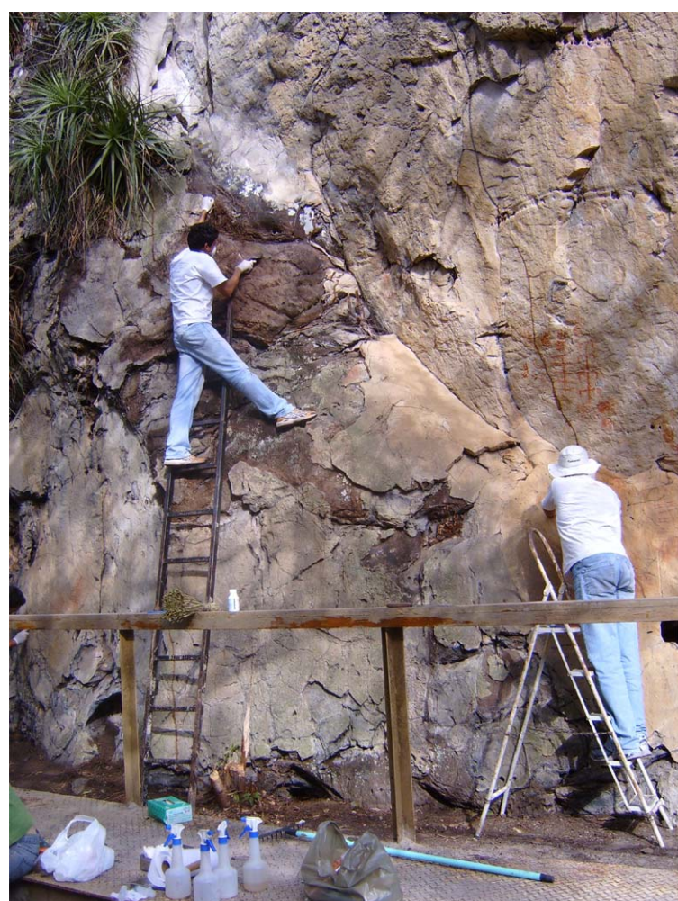
Fig. 3 - Intervenções sendo realizadas
